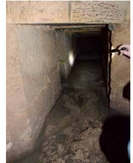
Schräg unter der Frauenkirche verlaufender Kanal
